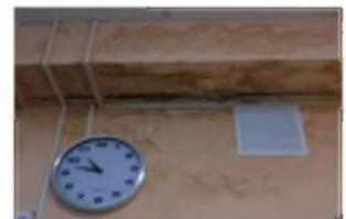
Дефекты укладки защитного слоя бетона
